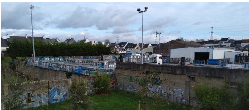
Site Air Liquide : vue du parc du Scarh
