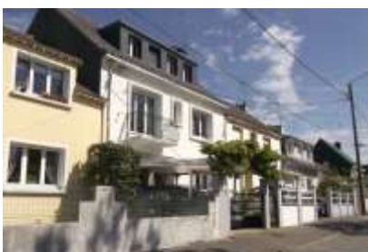
Lanester : tissu individuel continu. La maîtrise des implantations tant sur voie qu'en limites séparatives ainsi que celle des lignes d'égoût produit un paysage homogène et une forte présence architecturale.
