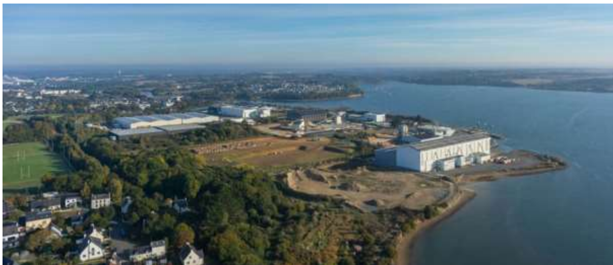
Vue de la pointe sud de la ZA du Rohu, avec au premier plan à droite les bâtiments de Kership
