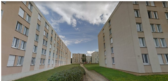
Immeubles en partie Est du site
