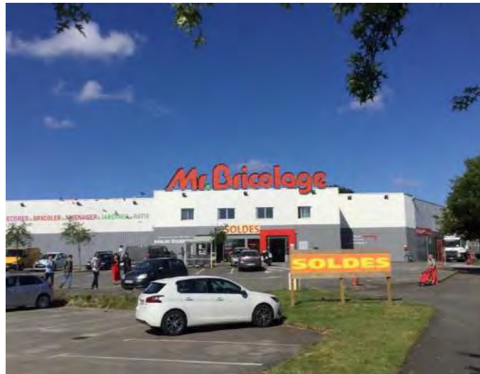
Enseignes sur toiture conforme au Code de l'environnement, Lanester, juillet 2019.
