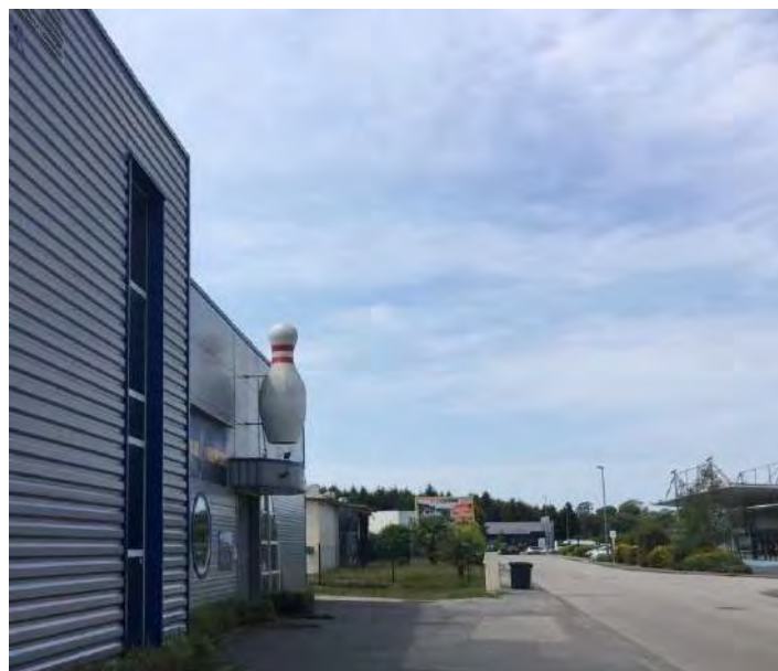
Enseigne perpendiculaire au mur dépassant des limites du mur, Lanester, juillet 2019.
